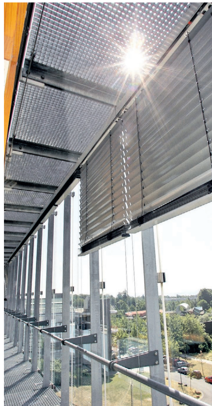
Die Lamellensysteme im Klinik-Neubau sind rund zwei Meter vor den Fenstern gebracht. Dazwischen kann die Luft zirkulieren.
